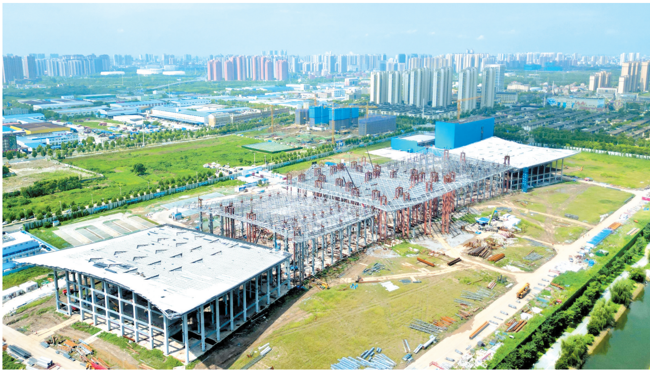
荆州新城江汉平原产业交流中心主体结构封顶。
