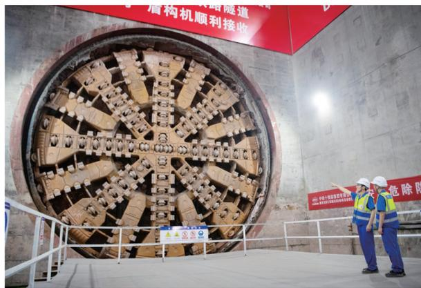
9月25日,渝昆高铁重庆菜园坝长江铁路隧道盾构段顺利贯通。重庆菜园坝长江铁路隧道是渝昆高铁全线关键控制性工程,位于重庆市渝中区与南岸区,为单洞双线高速铁路隧道,全长11942米。
