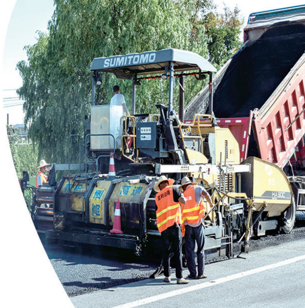
G351 监利段进行道路摊铺。
