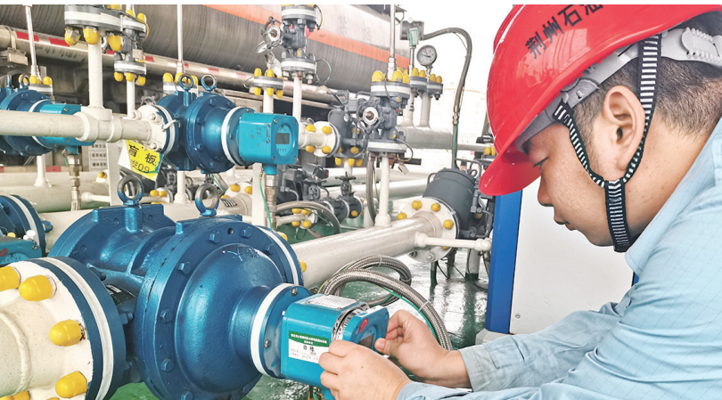
近日，中石化荆州分公司特邀省计量院荆州分院，对所属荆州油库7个在用发油台流量计开展检定工作，确保出库油品计量准确。(记者 潘路 通讯员 刘琦 吴盼 摄)
