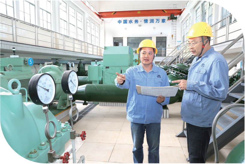
“双节”期间,荆州水务集团南湖水厂值班人员对制水工艺环节进行全面巡查,筑牢供水安全屏障。(记者 肖琦 通讯员 严瑾 摄)
