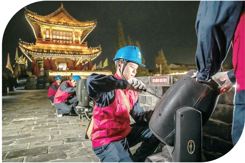
“双节”期间,国网荆州区供电公司荆东供电服务站员工在荆州东门景区维护景观灯电力供应。(通讯员 刘中平 记者 潘路 摄)
