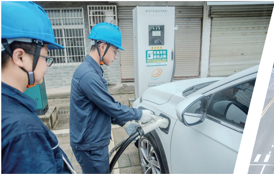
近日,国网荆州区供电公司雨台供电所所辖内国网新能源汽车充电点充电桩展开拉网式巡检,让车主充电无忧。(记者 潘路 通讯员 刘中平 摄)
