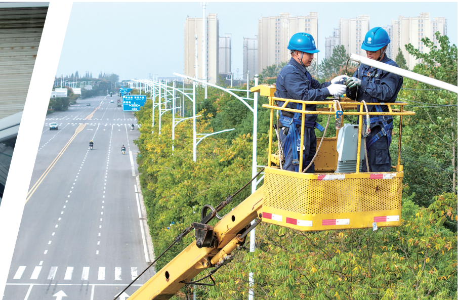
日前,市路灯管理服务中心为凤凰西路安装LED路灯。该中心加大中心城区主干道、工业园区区灯维修、换新工作,切实保障市民出行安全。(记者 梅闻 通讯员 李亚芳 摄)
