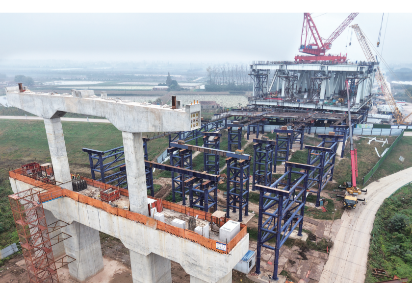
11月8日,在荆州李埠长江公铁大桥1标建设项目现场,架桥机高高耸立,施工人员正紧张有序地搭设通道、安装钢桁梁,现场一派忙碌景象。 截至目前,该项目共安装完成桩基1548根、桥面板38片、钢桁梁2100片,预计今年年底完成跨堤钢吊索桥上部工程。 (记者 梅闻 通讯员 金波 摄)
