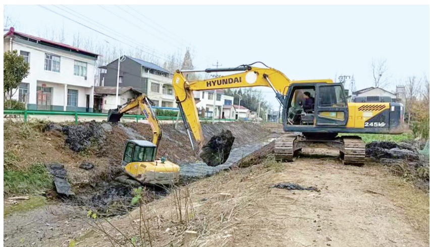
近日,高陵镇晏家巷村抢抓冬闲“黄金期”,对新华沟进行清淤,以改善农田灌溉条件,提高沟渠蓄水量。(通讯员 苏婷 蔡谦 摄)
