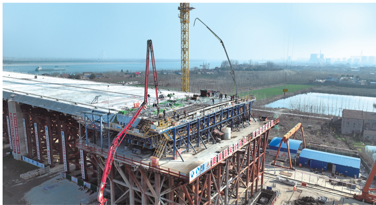
项目团队对钢筋加工、模板安装、混凝土浇筑与养护、预应力张拉等每一道工序进行精细化控制，确保结构尺寸、保护层厚度、混凝土强度等关键指标满足设计及规范要求，为后续的节段梁胶拼毫米级精度控制奠定坚实基础。
