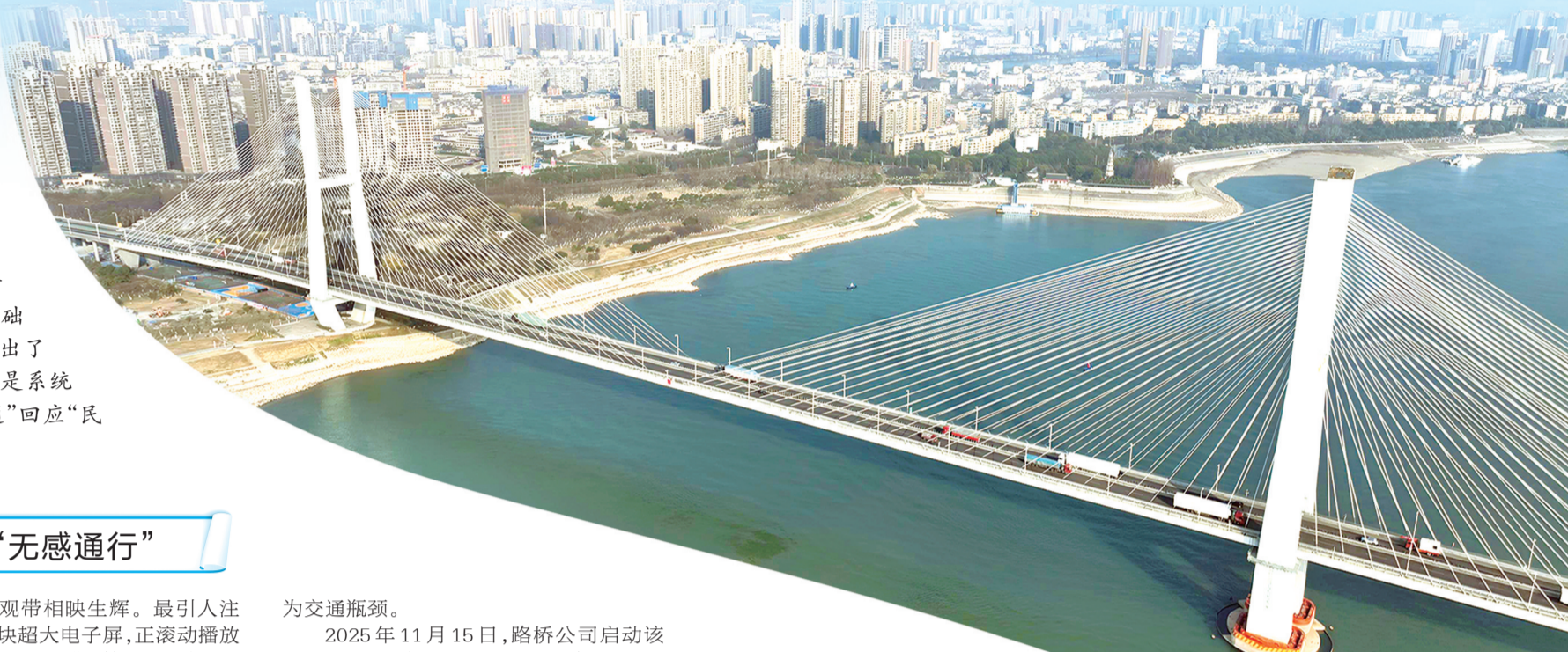
航拍荆州长江公路大桥。
