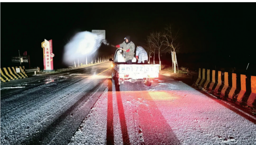
天鹅洲开发区增加坡道、桥梁等重点部位撒盐作业频次。(通讯员 徐永福 吴爽 摄)
