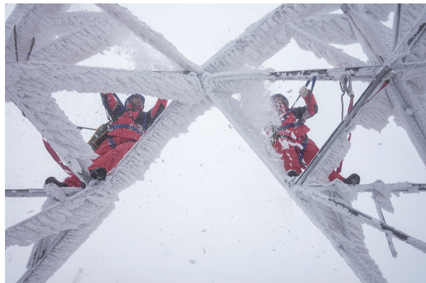
1月21日,在鹤峰县走马镇,抢修人员在35千伏电力线路铁塔进行人工除冰作业。近日,湖北省迎来大范围低温雨雪冰冻天气,部分高海拔地区电力线路覆冰严重。正值岁末年初用电高峰,省内地供电部门运维人员迎着风雪巡线、排查、抢修,保障寒潮天气下电网安全稳定运行。(新华社发)
