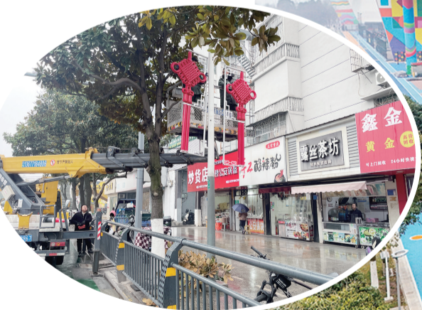
▲在荆州区的街道上,工人们正在安装亮化中国结。
