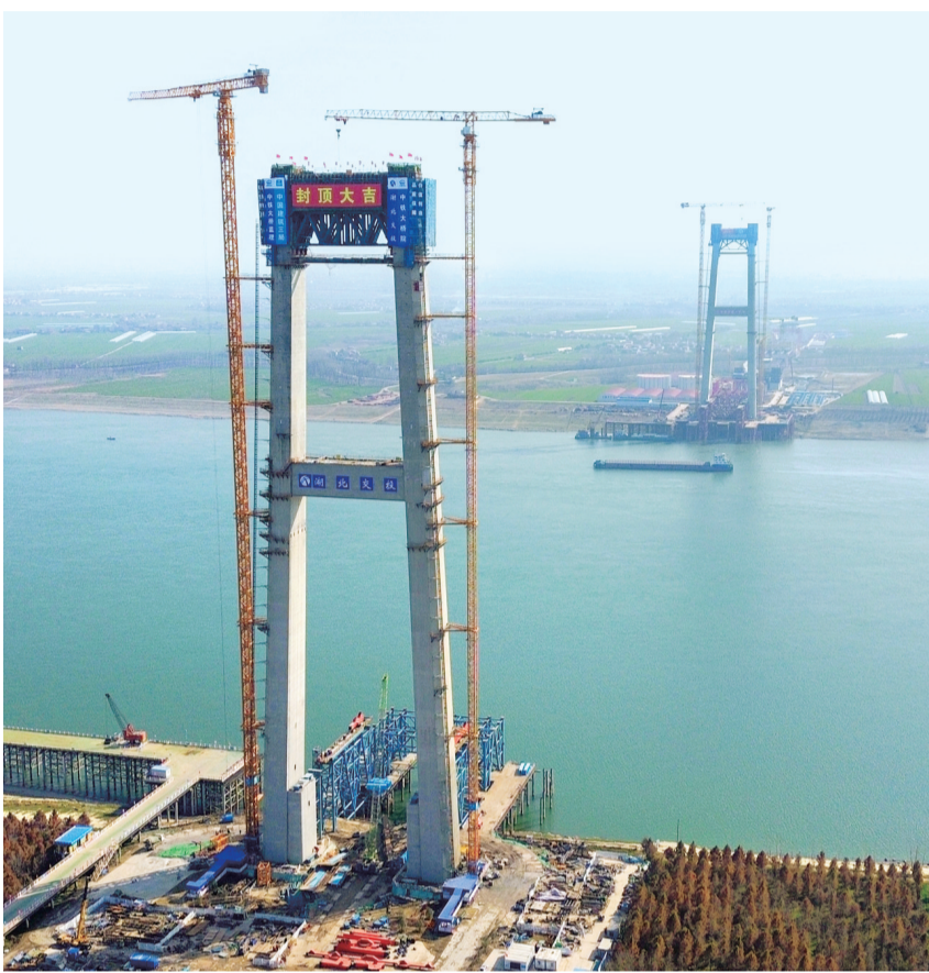
荆州李埠长江公铁大桥南北两岸主塔顺利完成封顶。
