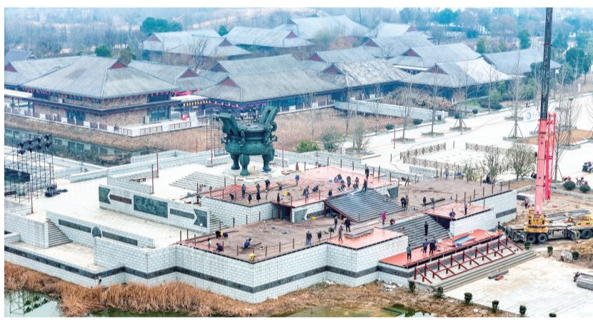
荆州方特楚文化数字产业园施工现场,展示了楚文化数字产业园的场景布置,包括传统建筑、灯光装饰等。
