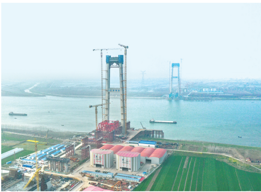
荆州李埠长江公铁大桥南岸主塔整体建设初步完工。(记者 叶力铭 梅闻 通讯员 范鹏 摄)
