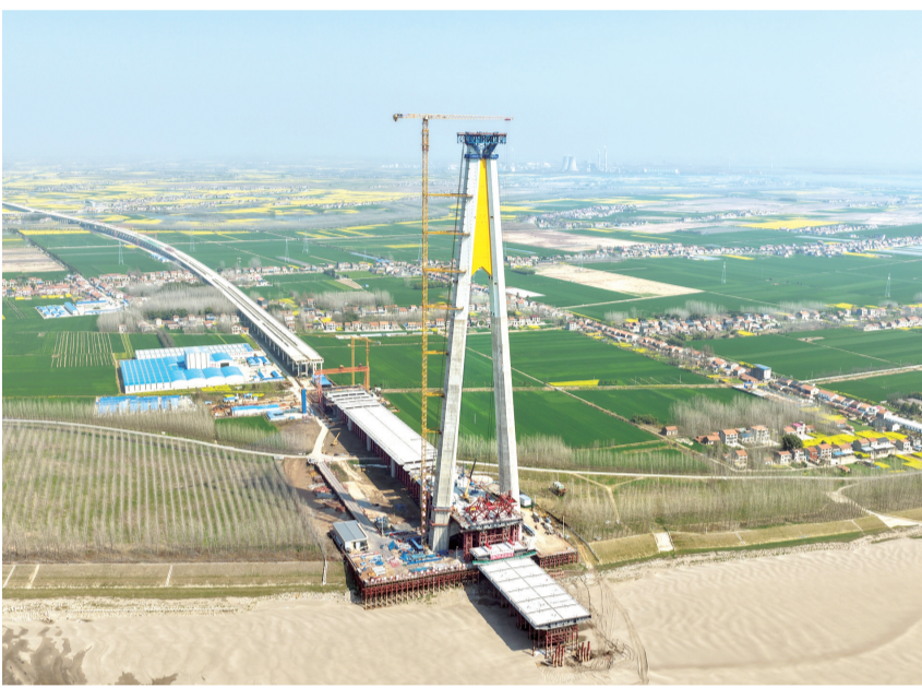
观音寺长江大桥建设有序推进。(通讯员 刘玉良 欧阳钰海 徐遵锐 摄)
