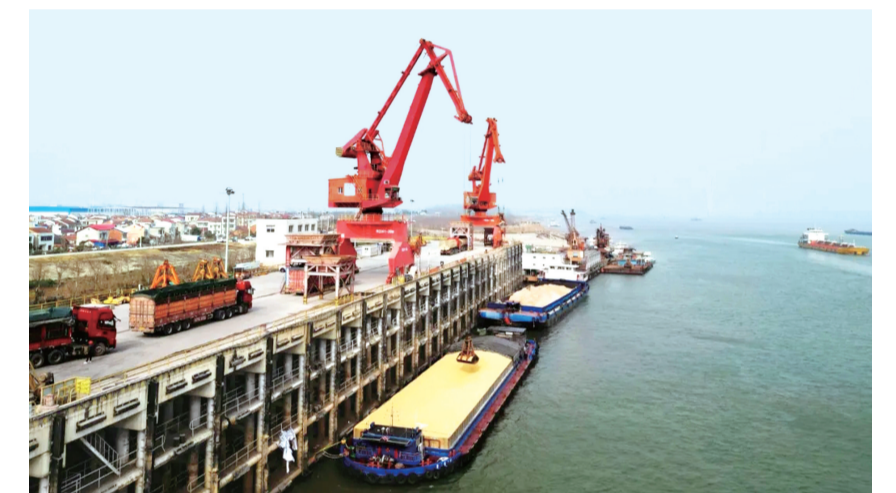
洪湖港有序开展车船直取作业,8000吨散粮玉米顺利入库。
