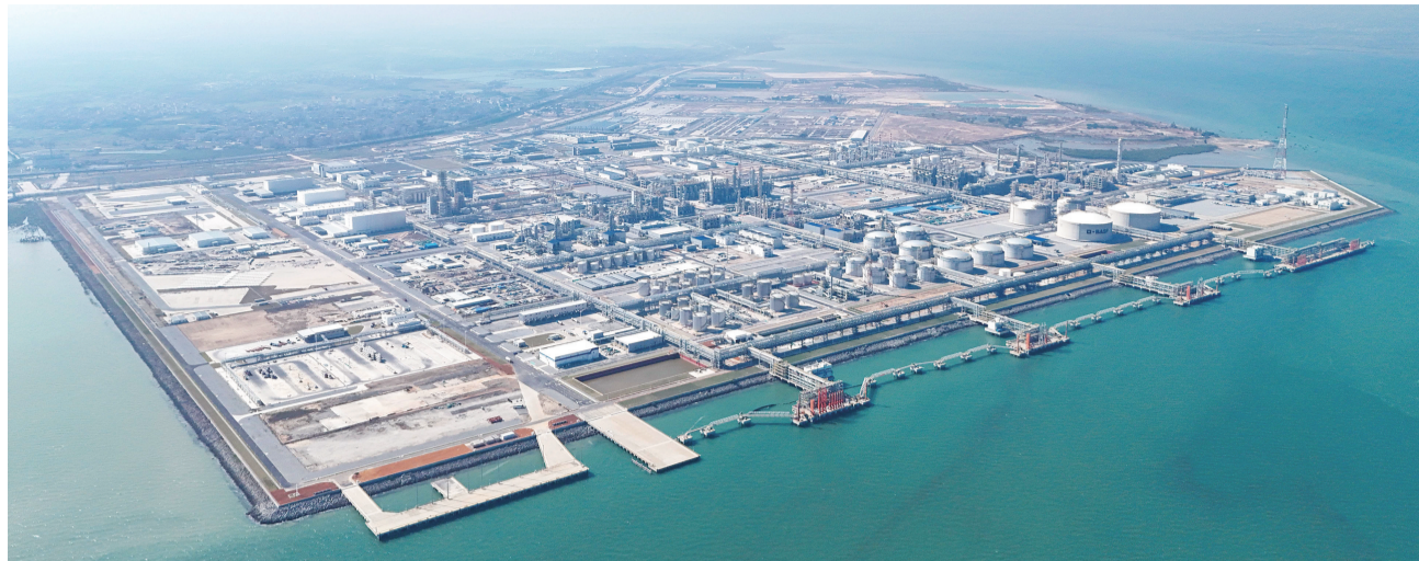
这是2025年12月11日拍摄的巴斯夫(广东)一体化基地航拍全景(资料照片)。2026年3月26日,巴斯夫(广东)一体化基地项目在广东省湛江市全面投产。这一项目总投资约87亿欧元,是德国企业在华投资规模最大的独资单体项目。(新华社发)
