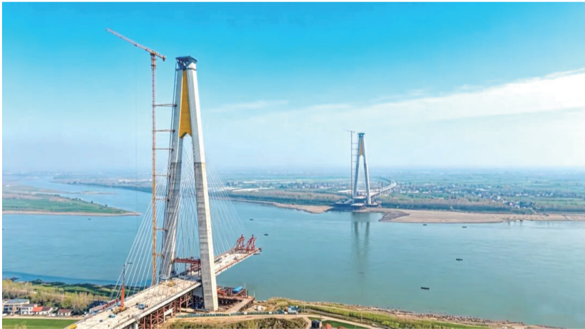
武松高速观音寺大桥建设正酣。
