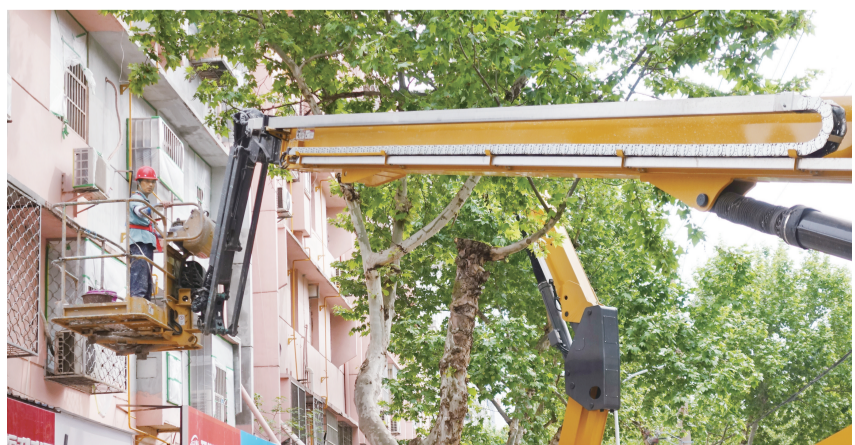
近日,在位于沙市区胜利街街道蛇上山社区江汉路的“巷往时光”特色街区外围建筑,施工人员进行彩绘墙准备工作,进一步提升“巷往时光”视觉吸引力。(记者 潘路 通讯员 周敏 摄)
