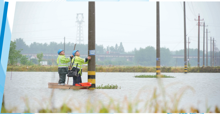
5月18日,公安县南平镇多处虾塘水位上涨阻断通行,国网荆州供电公司工作人员冒雨抢修10千伏水鱼山线水塘区段开展巡线,确保辖区供电稳定。(通讯员 郑晓龙 摄)
