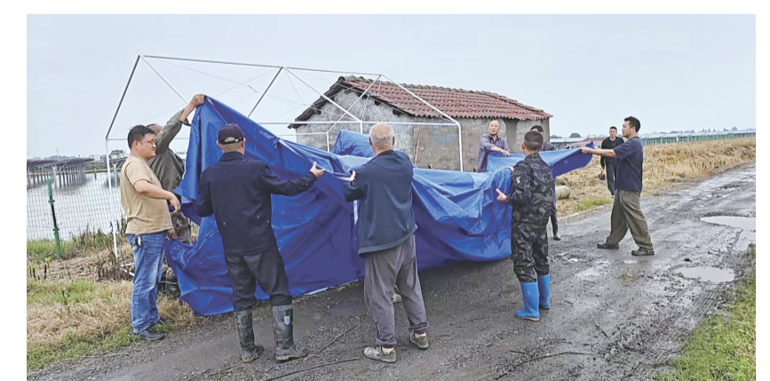
在纪南镇拾桥河堤官坪村断面,防汛人员搭建帐篷,做好各项准备工作。
