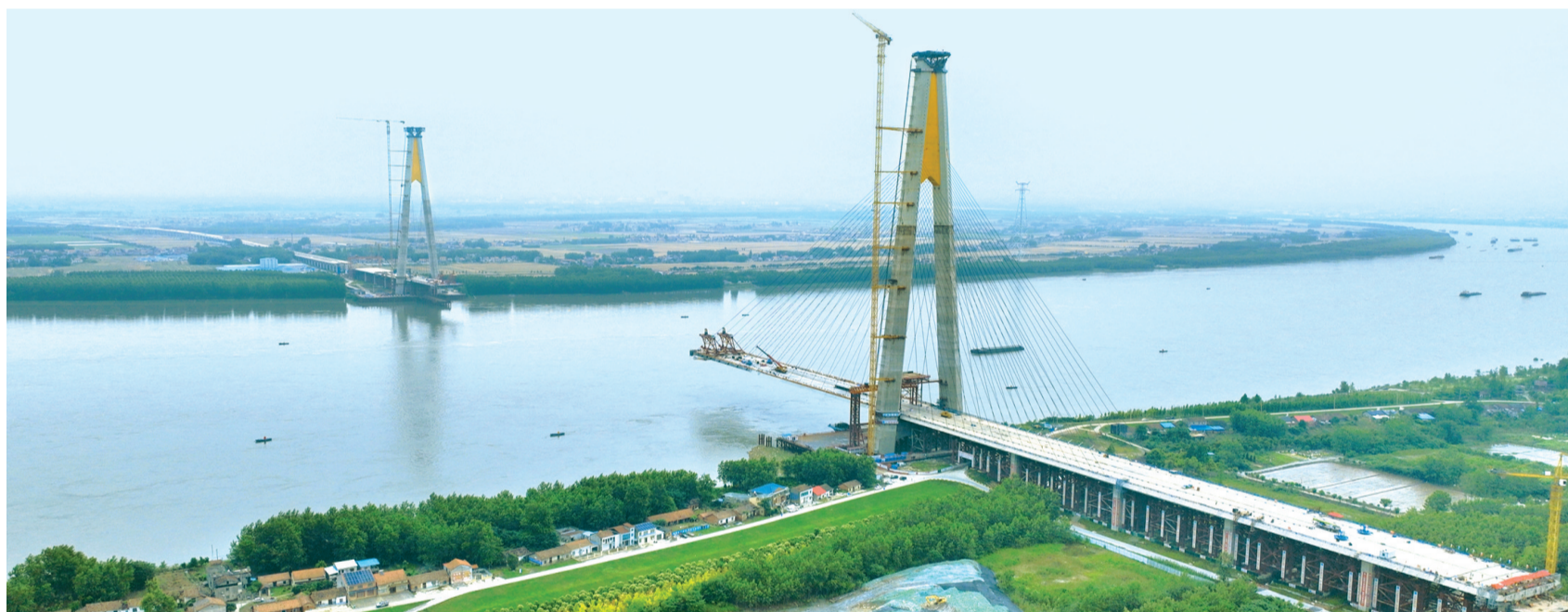
观音寺长江大桥公安侧边跨顺利合龙。
