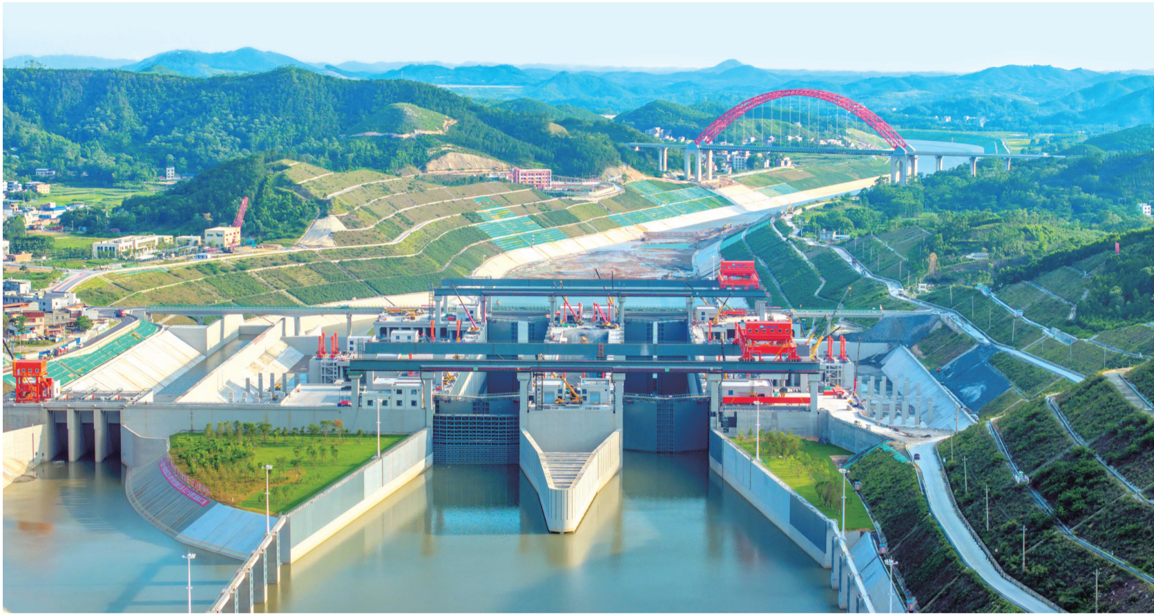
这是6月3日拍摄的广西平陆运河马道枢纽充水现场(无人机照片)。6月3日,随着平陆运河马道枢纽和企石枢纽正式开始充水,平陆运河全线通水,全面进入有水调试阶段。
