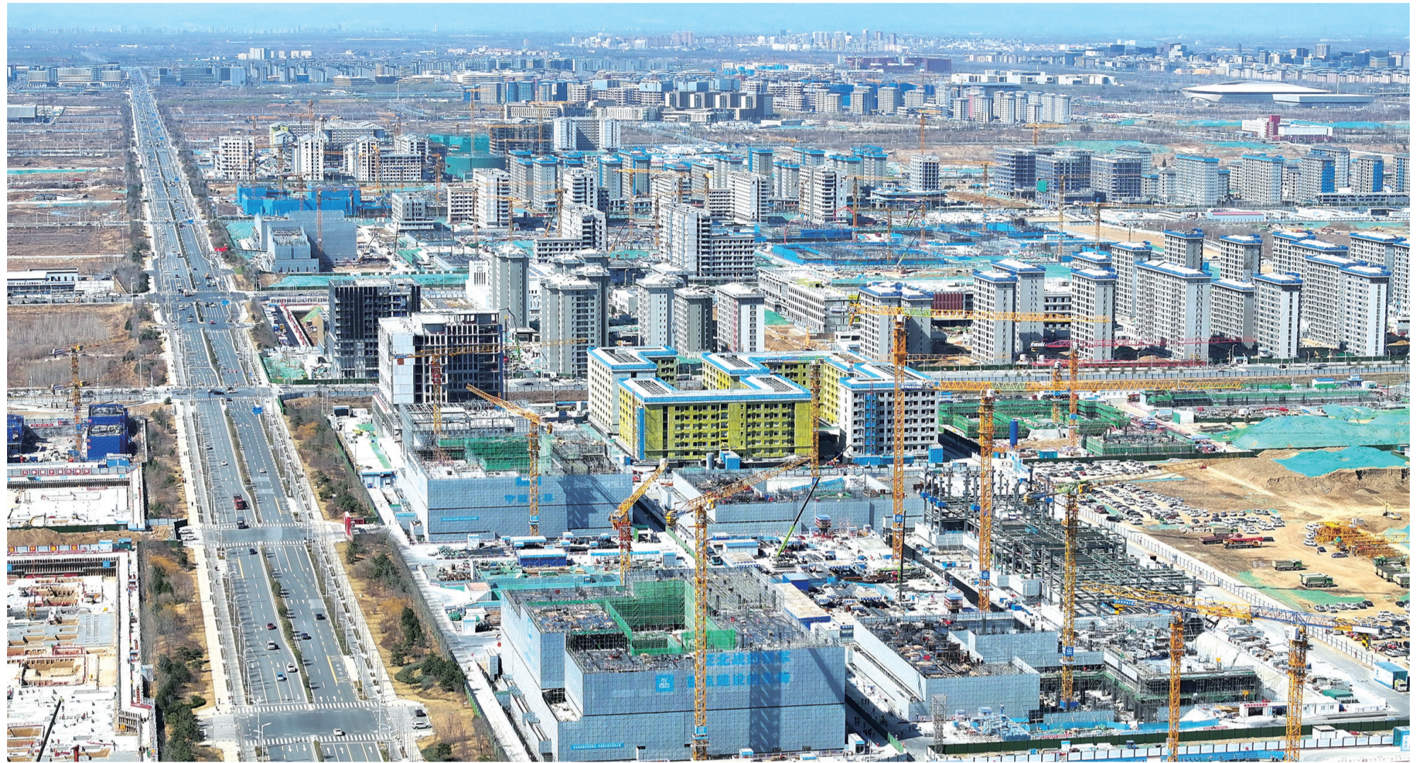
这是2026年3月18日拍摄的位于雄安新区起步区第五组团的首批北京疏解高校雄安校区建设现场(无人机照片)。(新华社发)
