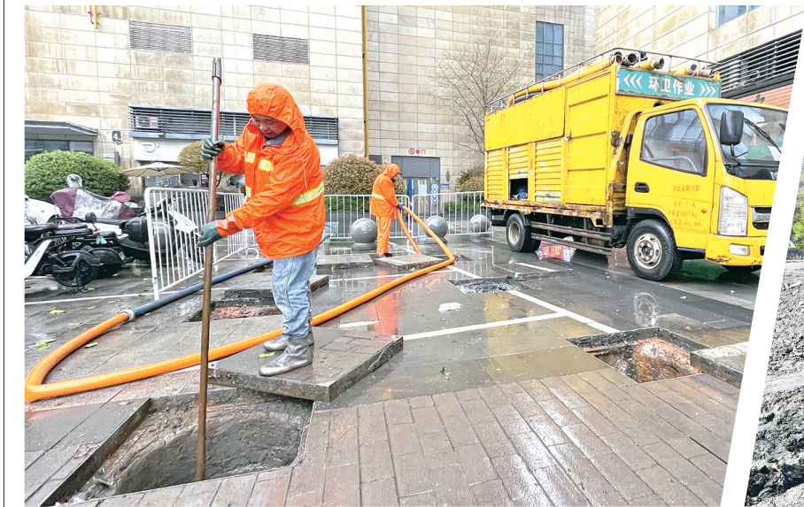
日前,在沙市区便河西路附近,市环卫工人采取机械清淤与人工清理相结合的方式,开展排水管网清淤疏浚工作,确保城区排水管网安全畅通运行。(潘路 摄)
