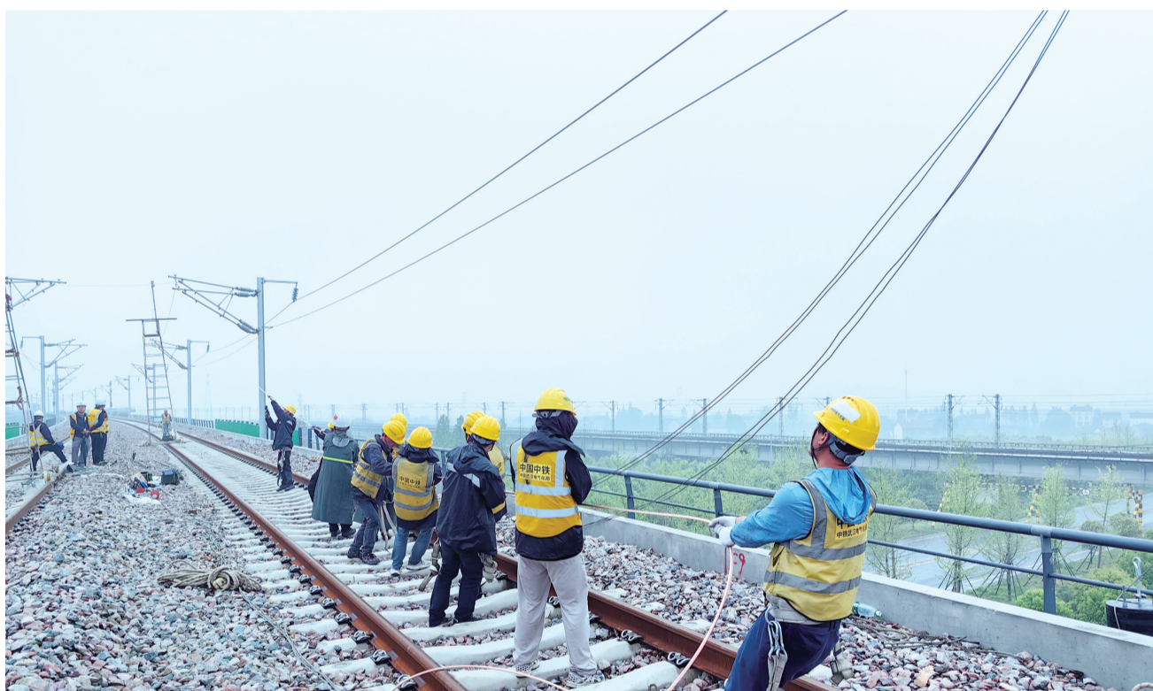
在工作人员的努力下,荆荆高铁首条接触网承力索完成架设。
