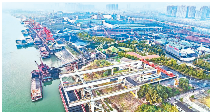
荆州港盐卡港区的一处铁水联运码头。(湖北日报全媒体记者 刘曙松 摄)
