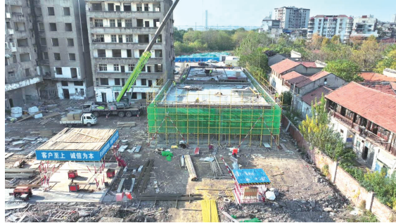
中山路专职消防救援站即将完工。
