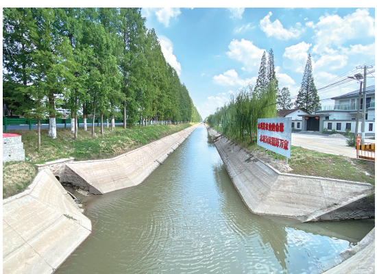
公安县深入实施灌区改造工程,实现水畅水清岸美。
