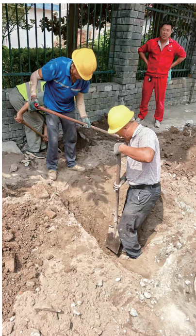
工程人员在吊脚楼沿线路施工。
