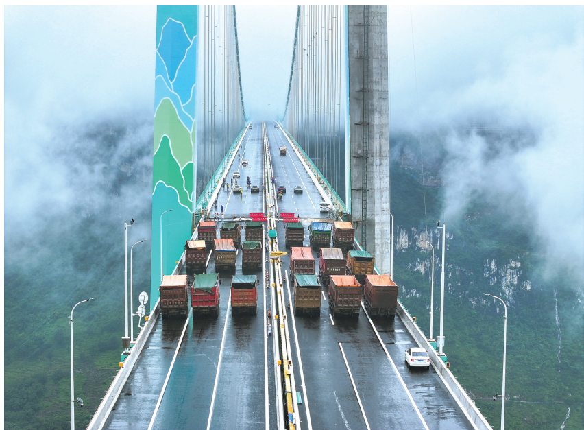
8月21日,在建世界第一高桥——贵州花江峡谷大桥正式启动荷载试验。2022年开工建设的花江峡谷大桥,跨越被誉为“地球裂缝”的花江大峡谷,是贵州省六枝至安龙高速公路的控制性工程。大桥为钢桁梁悬索桥,全长2890米,其中主桥跨径1420米,桥面至水面高度625米。(新华社发)
