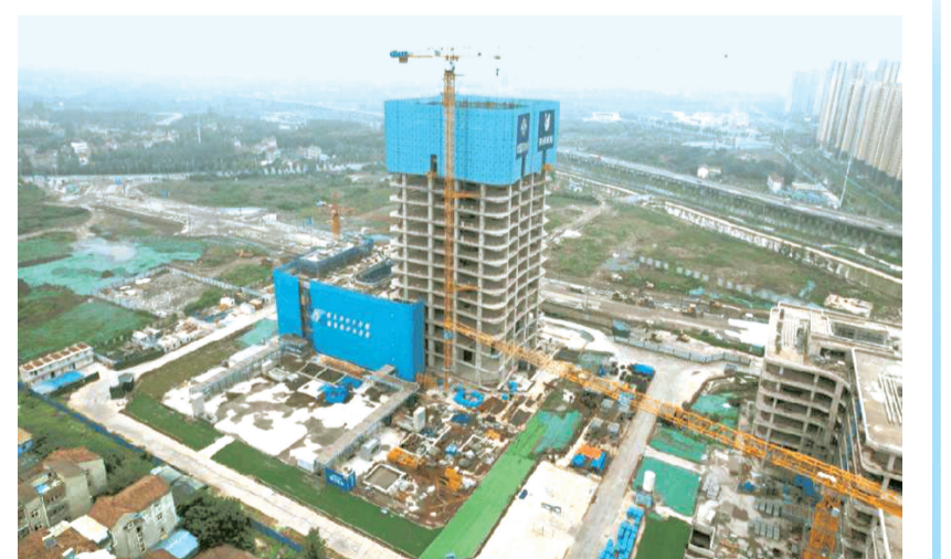
建设中的荆州新城一隅。
