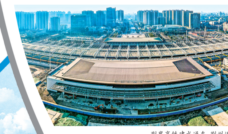
荆襄高铁建成通车,荆州进入高铁时代。
